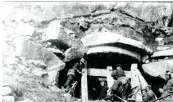
그림-2 석굴암의 돔 전면이 붕괴된 당시 모습의 사진
